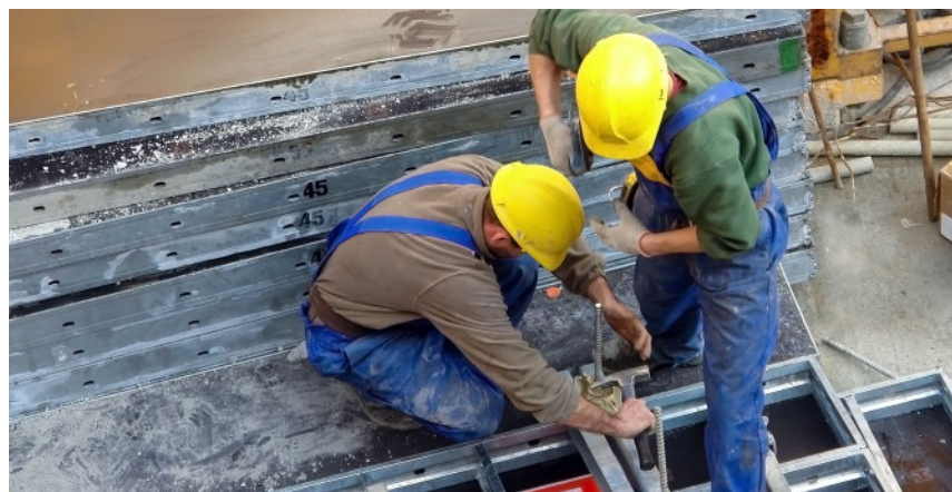
Zwei Meter Abstand halten – bei vielen Tätigkeiten auf der Baustelle ist das schwierig.
